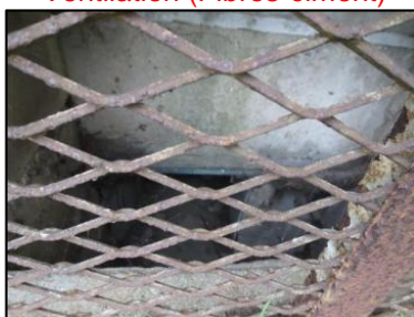
Photo N° 2730 ECH-N°30 AMIANTE CIMENT 32--Façade Conduits accès vide sanitaire Ventilation (Fibres-ciment)
