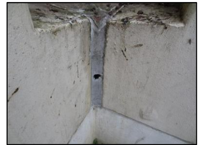
Photo N° 2706 ECH-N°27 3-- Façade Murs Joint de dilatation + mousse
