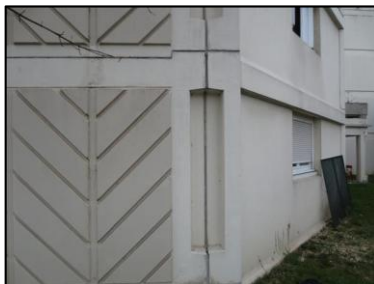
Photo N° 2665 ECH-N°11 32-- Façade Murs Béton + peinture
