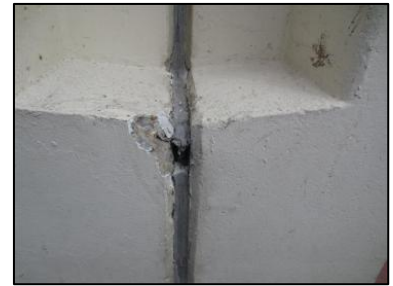
Photo N° 2701 ECH-N°24 3-- Façade Murs Joint de dilatation + mousse
