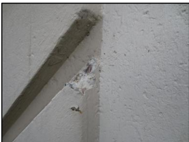
Photo N° 2664 ECH-N°10 32-- Façade Murs Béton + peinture
