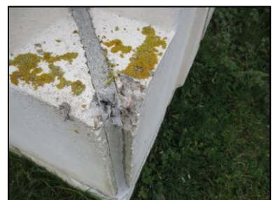
Photo N° 2731 ECH-N°37 21-- Façade Murs Béton + peinture
