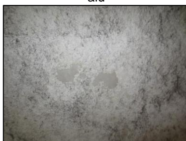
Photo N° 2784 ECH-N°61 FLOCAGE 21-Préau Plafond Flocage
