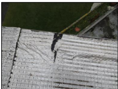
Photo N° 2810 ECH-N°58 REVETEMENT DE SOL 21-- Toiture-terrace Etanchéité Pax alu
