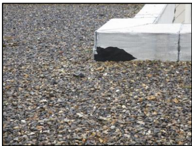
Photo N° 2802 ECH-N°56 REVETEMENT DE SOL 19-- Toiture-terrace Etanchéité Pax alu
