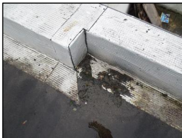
Photo N° 2781 ECH-N°55 REVETEMENT DE SOL 3-- Toiture-terrasse Etanchéité Pax alu
