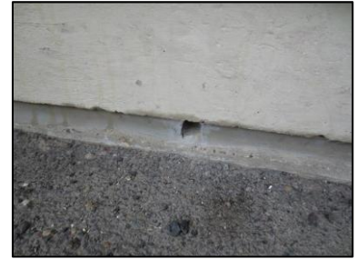
Photo N° 2651 ECH-N°2 32-- Façade Murs Joint de dilatation + mousse
