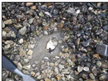
Photo N° 2749 ECH-N°47 REVETEMENT DE SOL 32-- Toiture terrasse Etanchéité sous graviers Bitume
