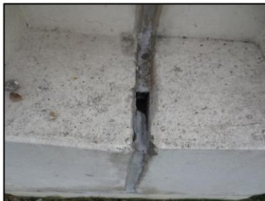
Photo N° 2662 ECH-N°8 32-- Façade Murs Joint de dilatation + mousse
