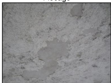
Photo N° 2786 ECH-N°63 FLOCAGE 30-Préau Plafond Flocage
