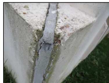
Photo N° 2736 ECH-N°40 21-- Façade Murs Joint de dilatation + mousse
