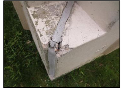
Photo N° 2718 ECH-N°33 7-- Façade Murs Béton + peinture
