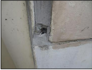
Photo N° 2709 ECH-N°28 5-- Façade Murs Joint de dilatation + mousse
