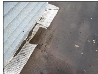
Photo N° 2782 ECH-N°54 REVETEMENT DE SOL 3-- Toiture-terrasse Etanchéité Bitume
