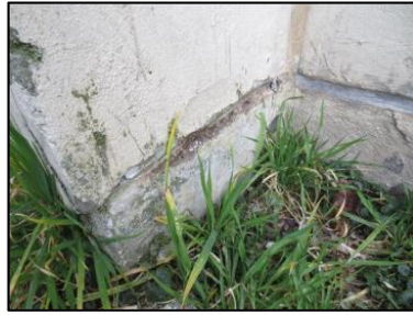
Photo N° 2678 ECH-N°17 28-- Façade Murs Joint de dilatation + mousse
