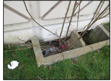
Photo N° 2713 ECH-N°30 AMIANTE CIMENT 5--Façade Conduit accès vide sanitaire Ventilation (Fibres-ciment)
