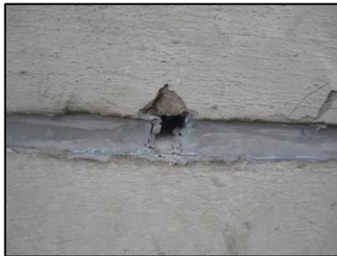
Photo N° 2656 ECH-N°5 32-- Façade Murs Joint de dilatation + mousse
