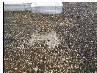
Photo N° 2759 ECH-N°49 REVETEMENT DE SOL 28-- Toiture - terrasse Etanchéité sous graviers Bitume
