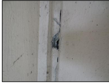
Photo N° 2673 ECH-N°14 30-- Façade Murs Joint de dilatation + mousse
