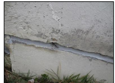
Photo N° 2663 ECH-N°9 32-- Façade Murs Joint de dilatation + mousse
