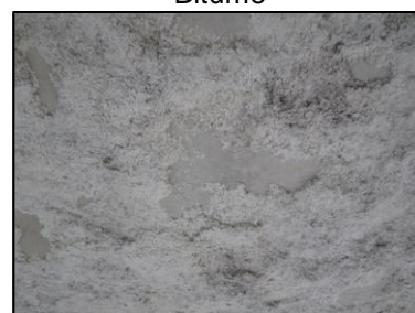
Photo N° 2785 ECH-N°62 FLOCAGE 28-Préau Plafond Flocage
