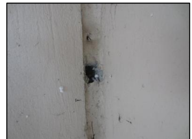
Photo N° 2669 ECH-N°12 30-- Façade Murs Joint de dilatation + mousse
