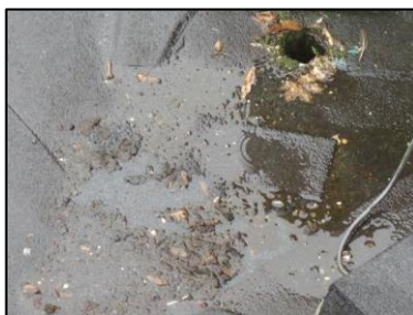
Photo N° 2761 ECH-N°51 REVETEMENT DE SOL 28-- Toiture - terrasse Etanchéité Bitume
