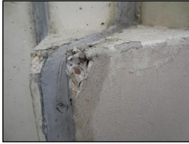
Photo N° 2710 ECH-N°29 5-- Façade Murs Béton + peinture
