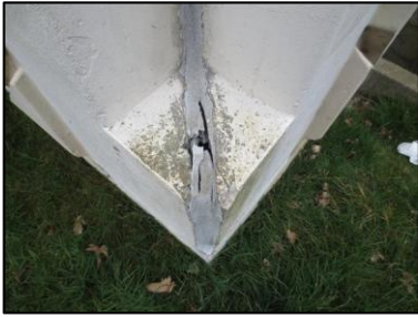
Photo N° 2714 ECH-N°31 5-- Façade Murs Joint de dilatation + mousse
