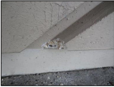
Photo N° 2677 ECH-N°16 28-- Façade Murs Béton + peinture
