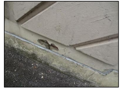
Photo N° 2694 ECH-N°21 1-- Façade Murs Béton + peinture
