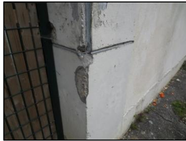
Photo N° 2698 ECH-N°23 1-- Façade Murs Béton + peinture
