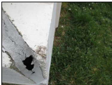
Photo N° 2740 ECH-N°42 19-- Façade Murs Béton + peinture
