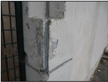
Photo N° 2697 ECH-N°22 1-- Façade Murs Joint de dilatation + mousse
