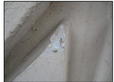
Photo N° 2657 ECH-N°6 32-- Façade Murs Béton + peinture
