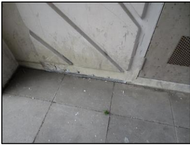
Photo N° 2682 ECH-N°18 28-- Façade Murs Joint de dilatation + mousse
