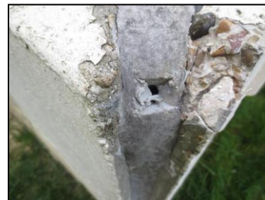
Photo N° 2743 ECH-N°43 19-- Façade Murs Joint de dilatation + mousse
