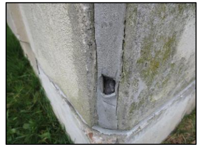
Photo N° 2723 ECH-N°35 7-- Façade Murs Joint de dilatation + mousse
