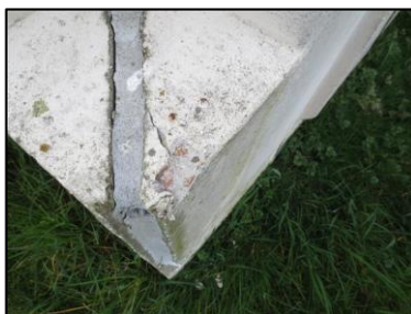
Photo N° 2735 ECH-N°39 21-- Façade Murs Béton + peinture
