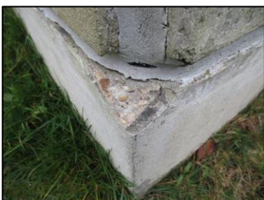
Photo N° 2724 ECH-N°36 7-- Façade Murs Béton + peinture
