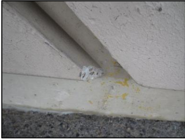
Photo N° 2670 ECH-N°13 30-- Façade Murs Béton + peinture
