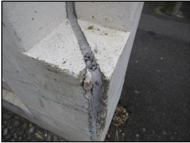
Photo N° 2649 ECH-N°1 32-- Façade Murs Joint de dilatation + mousse
