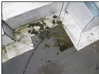
Photo N° 2767 ECH-N°52 REVETEMENT DE SOL 1-- Toiture-terrasse Etanchéité Bitume
