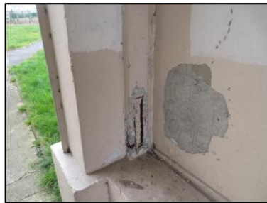
Photo N° 2705 ECH-N°26 3-- Façade Murs Béton + peinture
