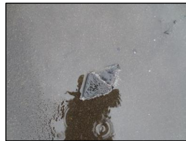
Photo N° 2809 ECH-N°59 REVETEMENT DE SOL 21-- Toiture-terrace Etanchéité Bitume
