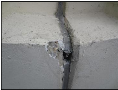
Photo N° 2702 ECH-N°25 3-- Façade Murs Béton + peinture
