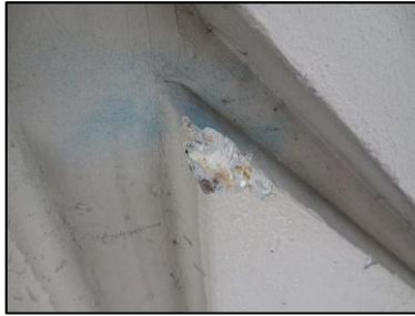
Photo N° 2650 ECH-N°3 32-- Façade Murs Béton + peinture
