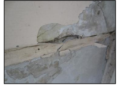
Photo N° 2674 ECH-N°15 30-- Façade Murs Béton + peinture
