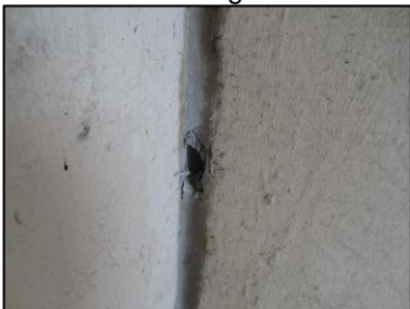
Photo N° 2660 ECH-N°7 32-- Façade Murs Joint de dilatation + mousse
