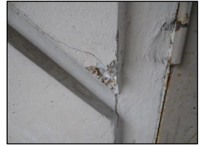
Photo N° 2681 ECH-N°19 28-- Façade Murs Béton + peinture
