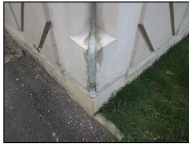
Photo N° 2693 ECH-N°20 1-- Façade Murs Joint de dilatation + mousse
