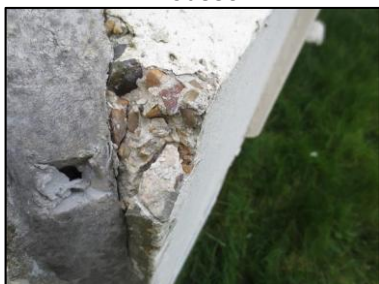
Photo N° 2744 ECH-N°44 19-- Façade Murs Béton + peinture
