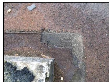
Photo N° 2748 ECH-N°46 REVETEMENT DE SOL 32-- Toiture terrasse Etanchéité Bitume
