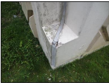
Photo N° 2719 ECH-N°34 7-- Façade Murs Joint de dilatation + mousse
