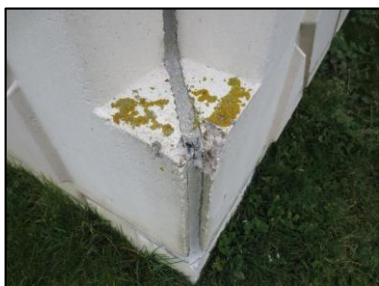
Photo N° 2732 ECH-N°38 21-- Façade Murs Joint de dilatation + mousse
