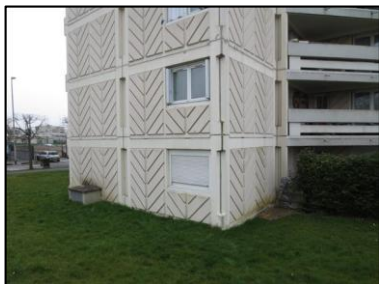
Photo N° 2737 ECH-N°41 19-- Façade Murs Joint de dilatation + mousse
