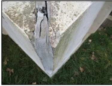
Photo N° 2715 ECH-N°32 5-- Façade Murs Béton + peinture
