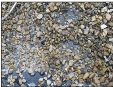
Photo N° 2803 ECH-N°57 REVETEMENT DE SOL 19-- Toiture-terrace Etanchéité sous graviers Bitume
