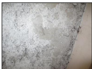
Photo N° 2783 ECH-N°60 FLOCAGE 19-Préau Plafond Flocage
